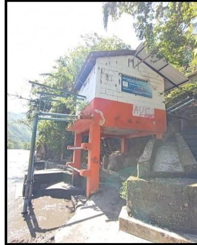
La captación se realiza sobre el río Negro durante ocho (8) horas al día aproximadamente, a través de un sistema de bombeo, la infraestructura de la captación es una bocatoma vertical de fondo, con válvulas de pie en broce, protegidas por mallas galvanizadas de 5 mm para evitar que ingresen solidos gruesos hacia la bomba de diámetro de 6" marca KSB, movidas por motores eléctricos de 36 trifásicos.
