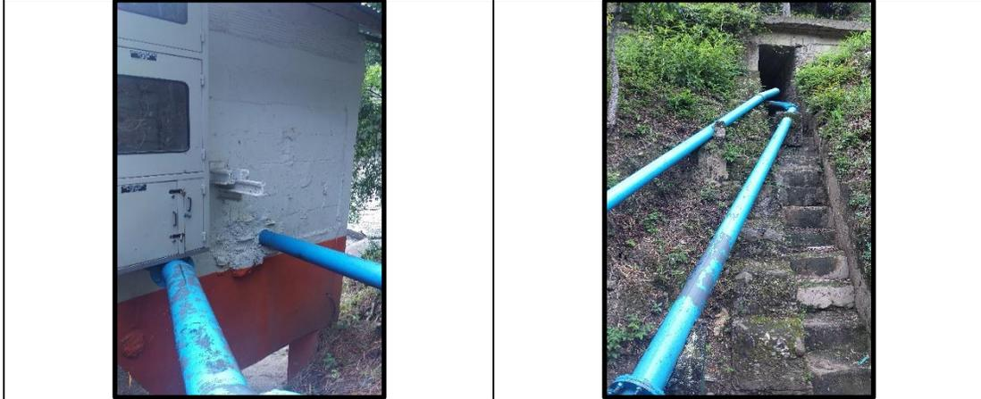
La tubería de aducción está construida en hierro acerado y PVC, cuenta con una longitud de 250 m lineales hasta llegar a la Planta de Tratamiento donde se encuentran ubicadas 2 válvulas para graduar el caudal de entrada. Este sistema tiene una cabeza hidráulica de 50 m.
